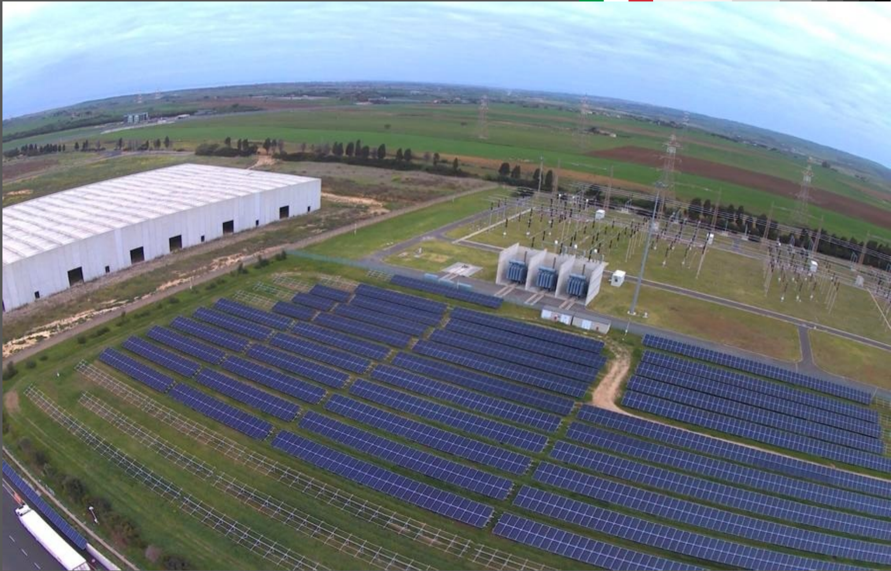
Tarquinia, Italia - P=2 MWp
