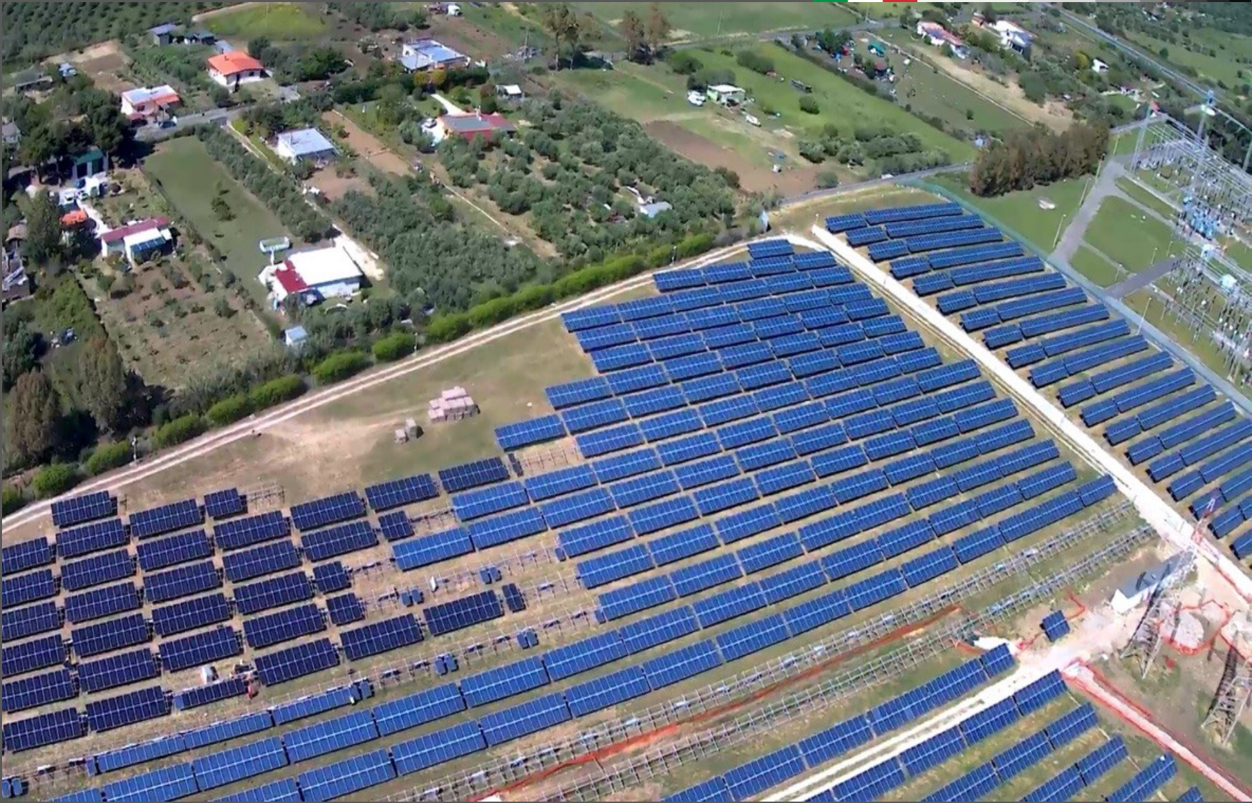
Civitavecchia, Italia - P=2,7 MWp
