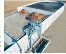
DETTAGLIO N.11-12: PLATEA STOCCAGGIO LETAME FRESCO- VASCA DI CARICO DIGESTORE
